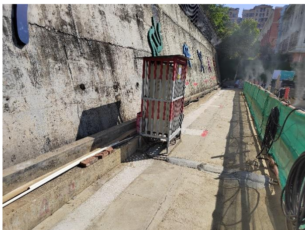
图 4.4-3 施工期间基坑排水沟
