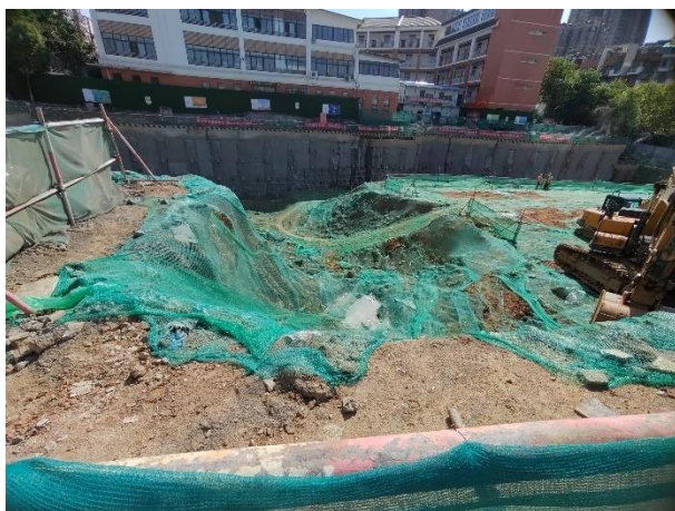
图 4.4-1 施工期间密目网临时遮盖
