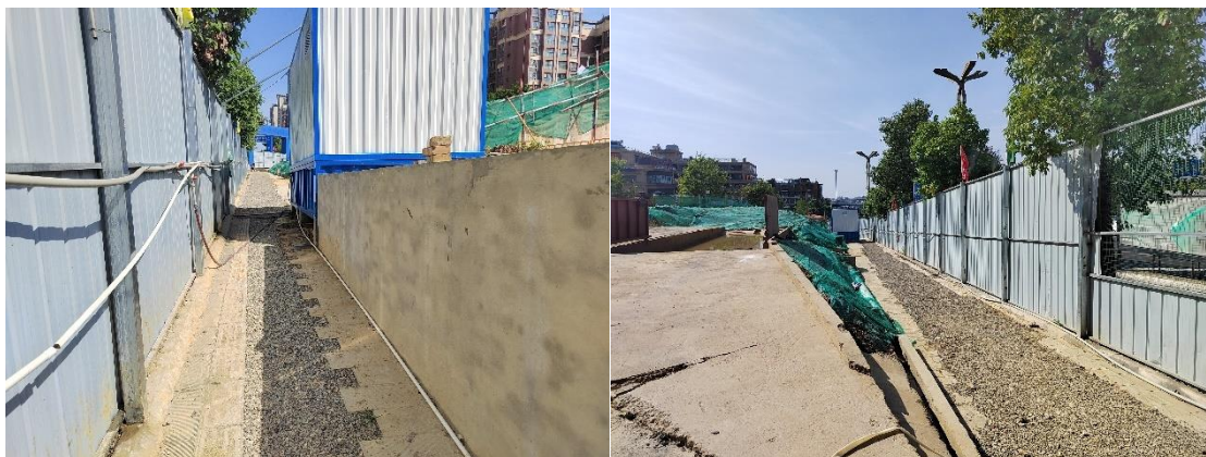
图 2.2-3 施工道路施工期间状况
