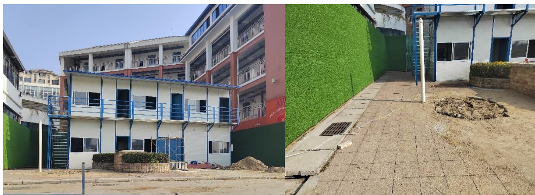
图 2.2-1 施工场地现状
